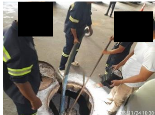
รูปที่ 39 การตัดไขมันจากบ่อดักไขมัน
